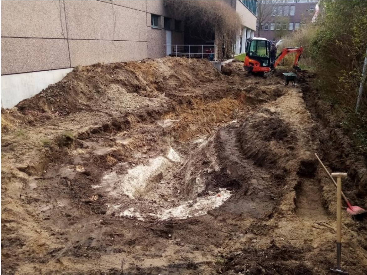
Aushub der Teichgrube (8.4.2021)
