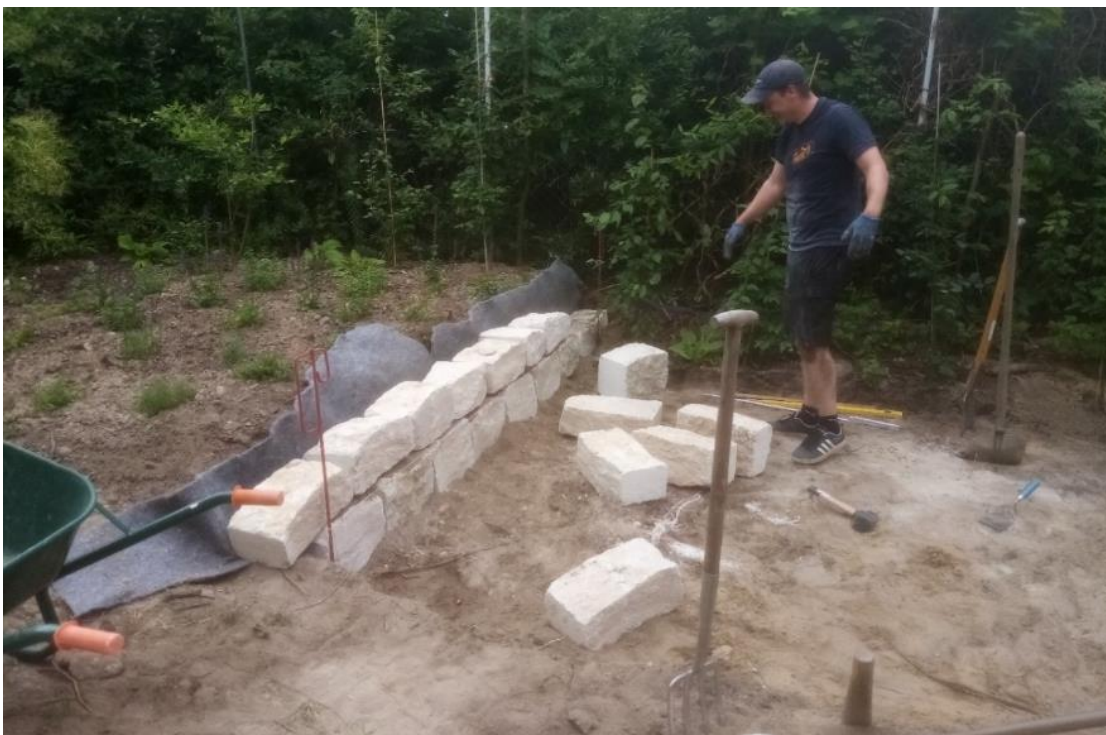
Harte Arbeit: Anlage des Sitzplatzes mit Sandsteinquadern als Trockenmauer (28.6.2021)
