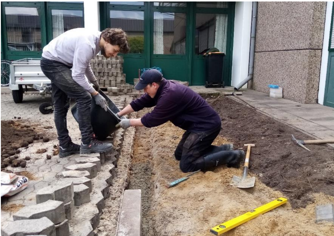
Vor Anlage des Beetes 2 wurde ein ca. 2 m breiter und 12 m langer Streifen des Parkplatzes entsiegelt und als Pflanzfläche für Stauden und vier Vogelbeerbäume vorbereitet.
