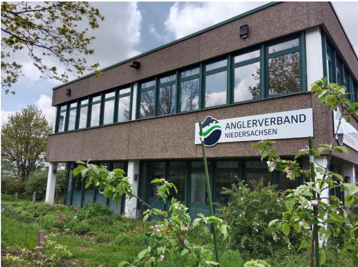
Eine ganze Serie von Nistkästen für Mauersegler sowie Turmfalken und Fledermäuse wurde in luftiger Höhe an der Fassade installiert (20.7.2021/ 23.2.2022).
