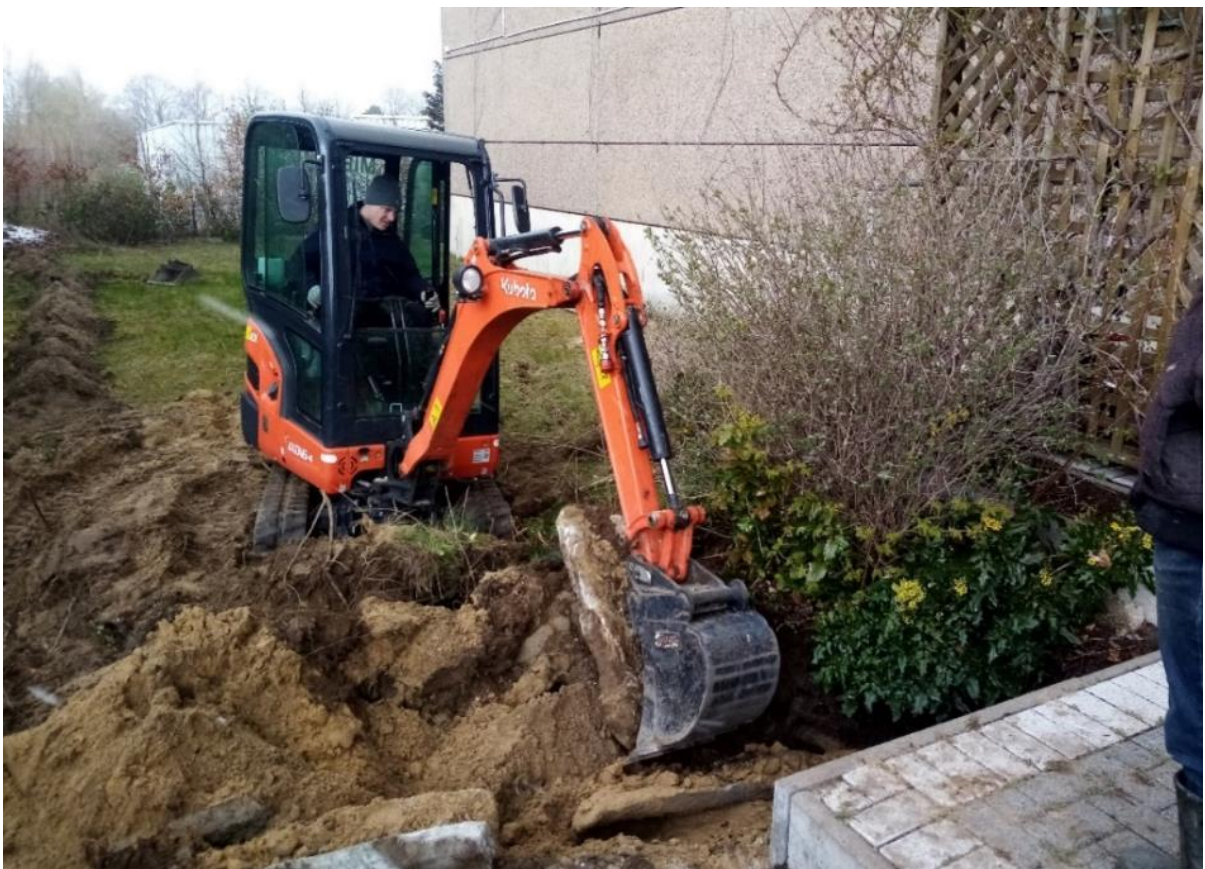
Entfernung standortfremder Gehölze und Betoneinfassungen in AVN-Eigenregie durch Helmut Speckmann (6.4.2021)
