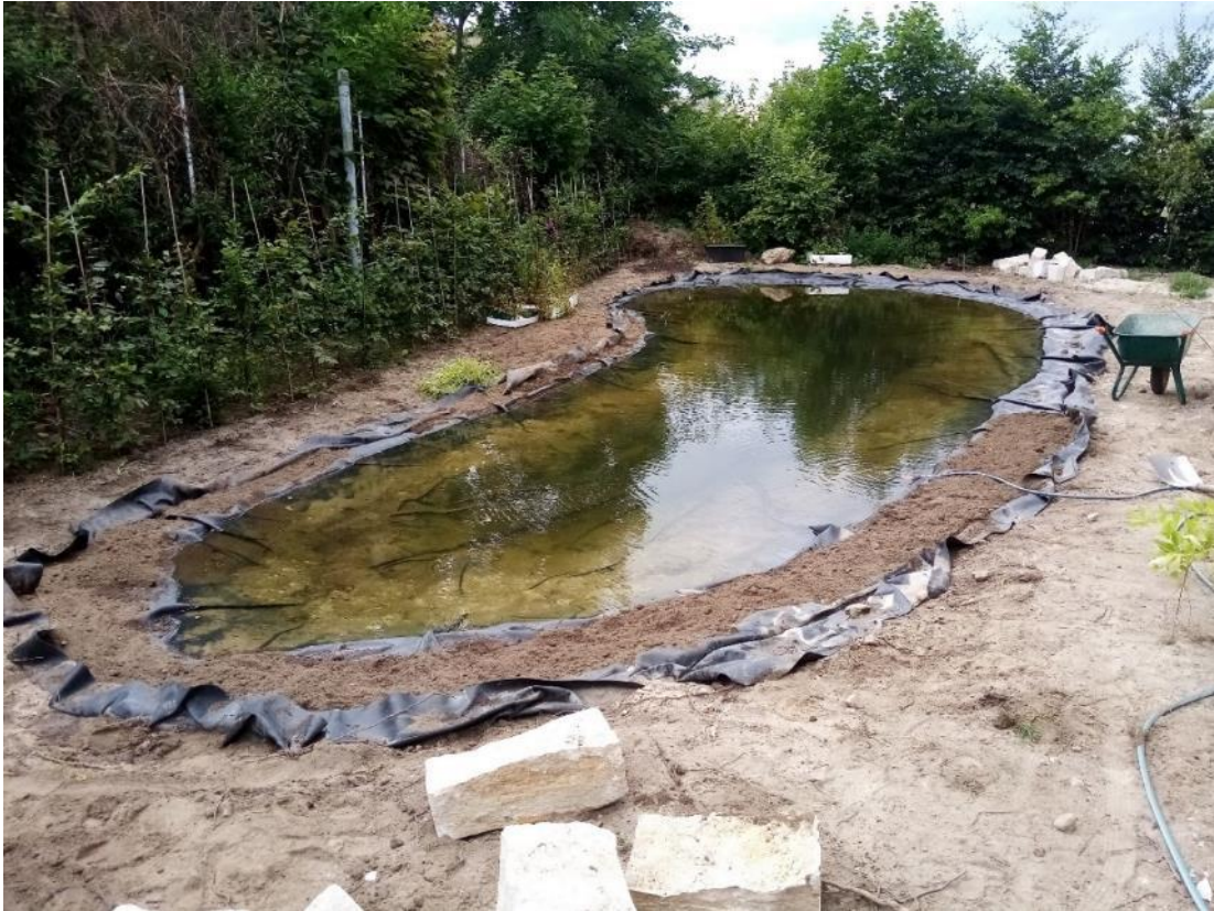
Die Uferbereiche werden mit magerem Substrat angefüllt und anschließend bepflanzt (14.7.2021)
