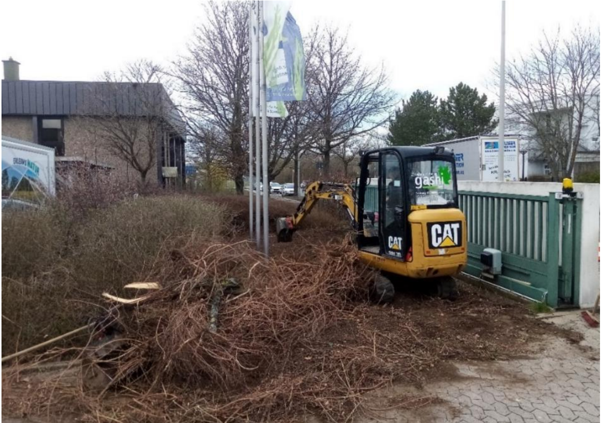
Entfernung standortfremder Gehölze vom 29.3. bis 30.3.2021 durch Firma GASHI Gartenbau
