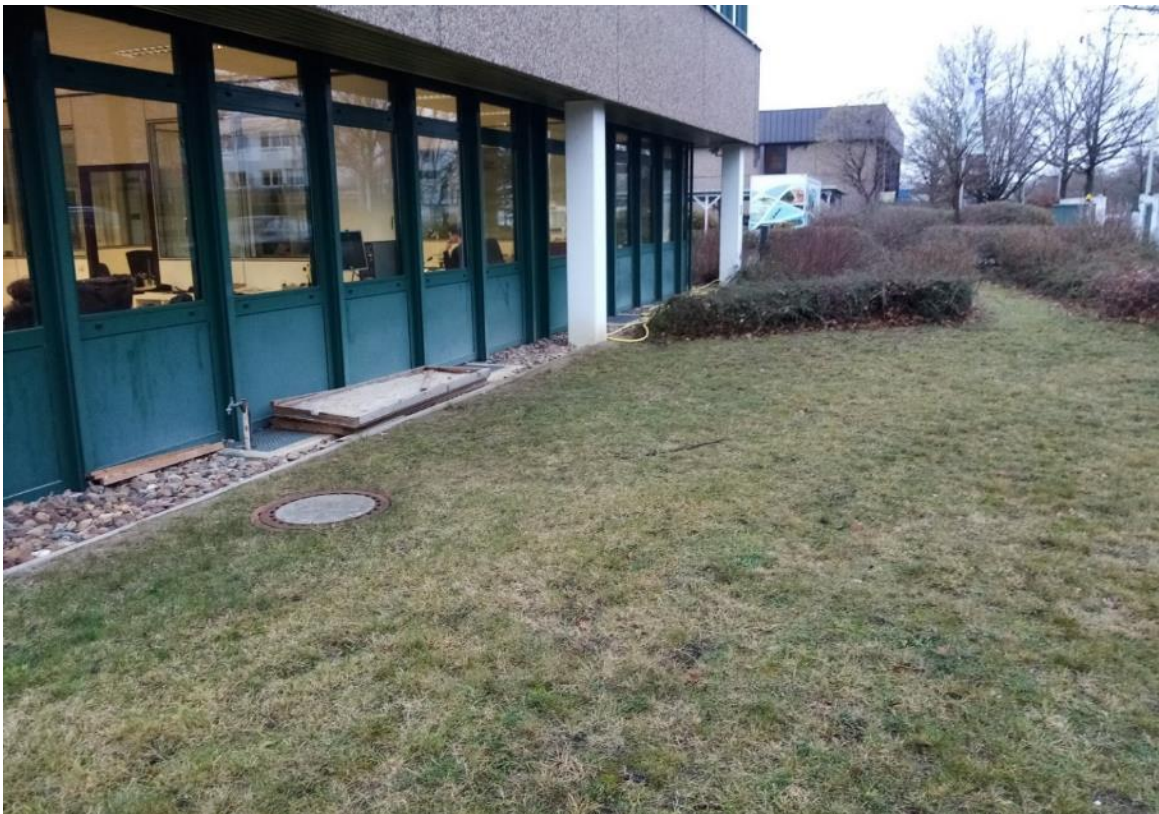
Beet 4 - vor der Maßnahmenumsetzung (Januar 2021)
