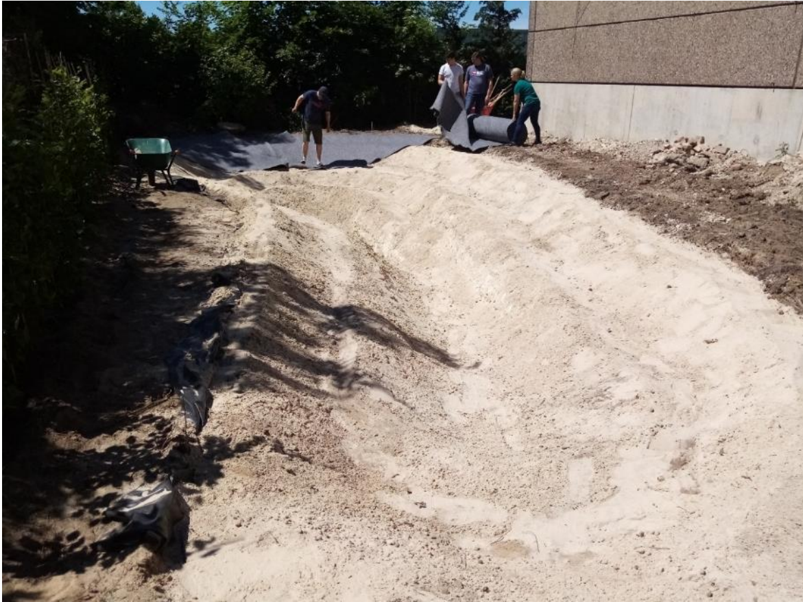
Auftrag der Sauberkeits- und Filterschicht sowie des Teichfließ (14.6.2021)
